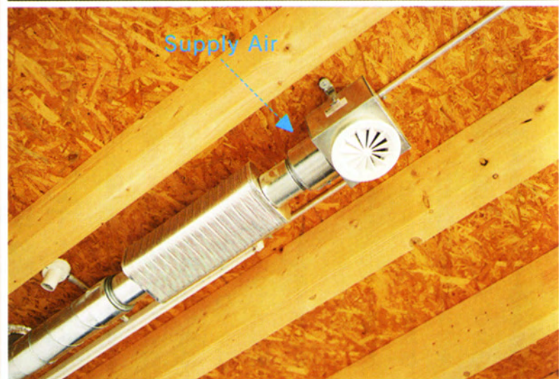
上・電力消費量の少ない蛍光灯を用いた照明器具。下・機械換気設備の給気口。コスト削減のために配管を化粧天井で隠している。気流は手をかざしてやっとわずかに感じられるほど。常に新鮮な空気があることによる快適感はとても大きい。左・2階の廊下を挟んで南側が居室、北側が浴室や洗濯室、機械室になっている。
