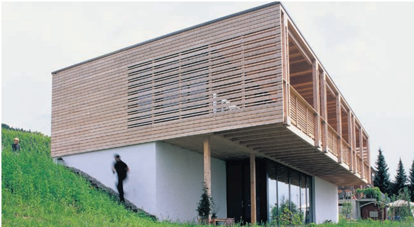
Leicht und unauffällig in den Südhang gebaut mit Fichtenholzschalung – wohnen und arbeiten im Minergie-P-Haus. Bilder: Thomas Drexel
