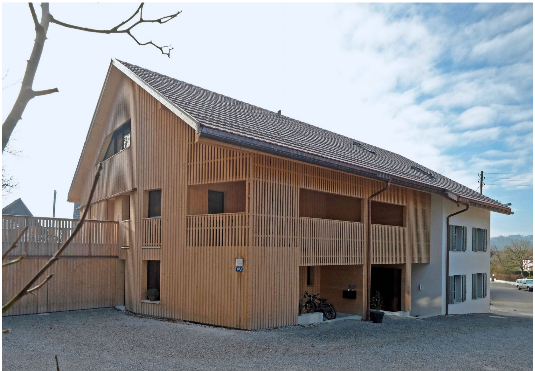
Drei in einem: Das Satteldach hält den einen Massivbau, ein schmales Mittelhaus und den grossen Holzbau zusammen (v. r.)
