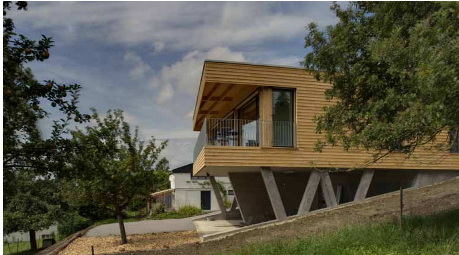
Inspiriert von den Pfahlbauten fusst das eingeschossige Passivhaus in Nussbaumen auf Pfählen aus Beton. Es erhielt den Thurgauer Energiepreis 2011 in der Kategorie Neubau. (Bilder: Bauatelier Metzler, Hüttwilen)
