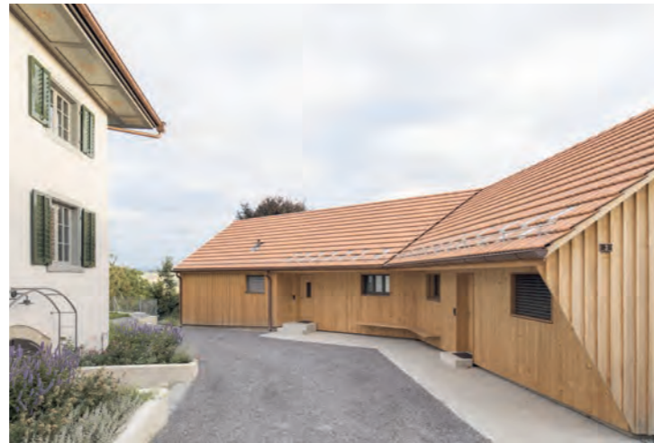
OBEN Der sanierte Altbau mit dem neu errichteten Holzbau
