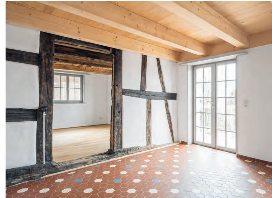
UNTEN Wohngeschoss mit erhaltenen Fachwerkteilen
